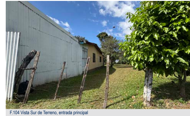
F. 104 Vista Sur de Terreno, entrada principal
